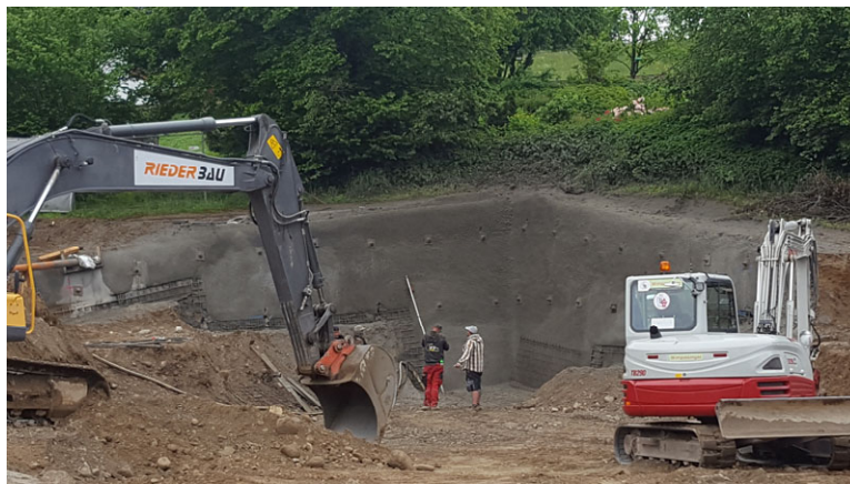
Abbildung 2.6-2: Baugrubensicherung
