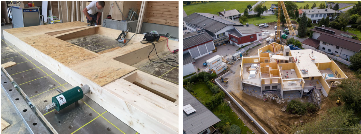
Abbildung 2.6-5: Vorfertigung einer Wand in Werkshalle und Montage eines Deckenelements auf der Baustelle
