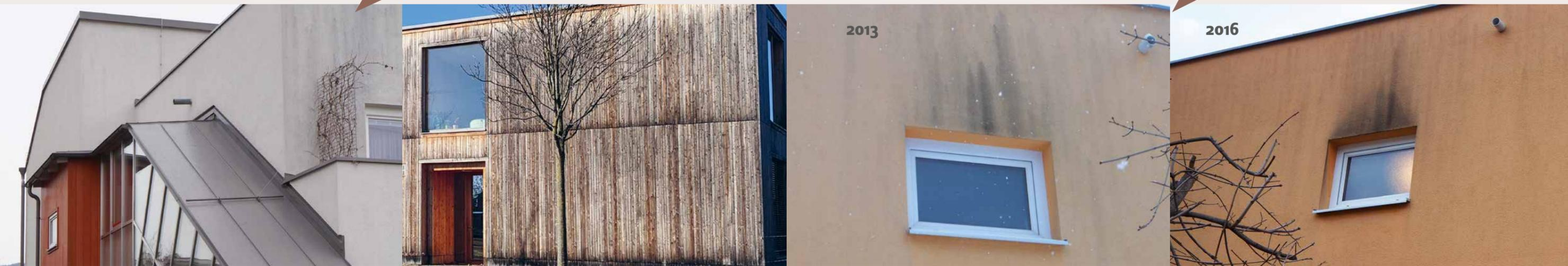
Die am häufigsten festgestellte Beeinträchtigung von WDVS-Fassaden ist der Befall durch mikrobiellen Bewuchs (Veralgung). Das optische Erscheinungsbild dieser Fassaden macht eine Reinigung und Überarbeitung bereits nach wenigen Jahren notwendig, der technische Zustand ist jedoch noch gewährleistet. Bei den untersuchten Fassaden ist mit zunehmender Dämmstoffstärke eine allseitige Veralgung feststellbar, unabhängig von der Himmelsrichtung oder von Pflanzenbestand in der unmittelbaren Umgebung.
