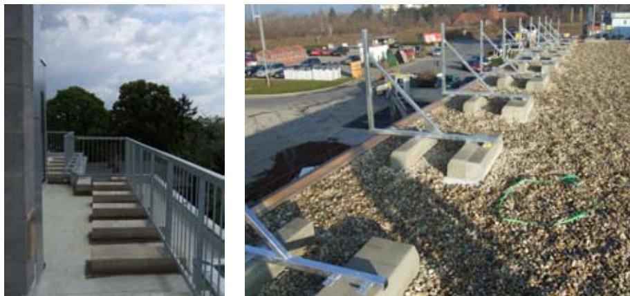
Abbildung 5: Betonfundamente für Geländer bzw. Werbetafeln
