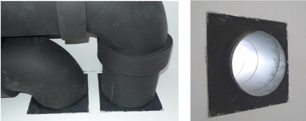
Abbildung 6: rechteckige EPDM-Gummimanschetten für luftdichte Außenwanddurchführung von Lüftungsrohren
