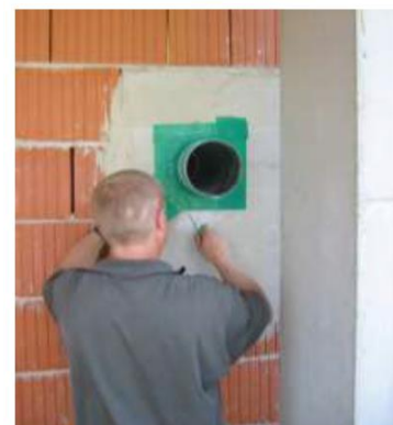
Abb. 3-74: Fortluftdurchführung durch Ytongfeld
