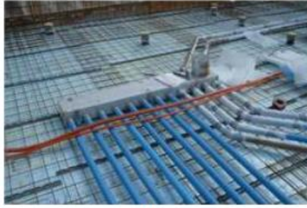
Starre Luftleitungen in der Betondecke (Quelle: Poloplast zw. SM-Heag)
