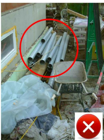
Abbildung 32: Nicht korrekt gelagerte Rohre (links), während der Bauphase verschlossene Rohrleitung (Leitzinger, 2013)
