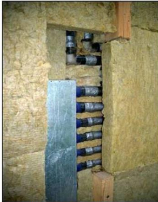
Abbildung: Leitungsführung in der Außendämmung (Quelle: AWEL)
