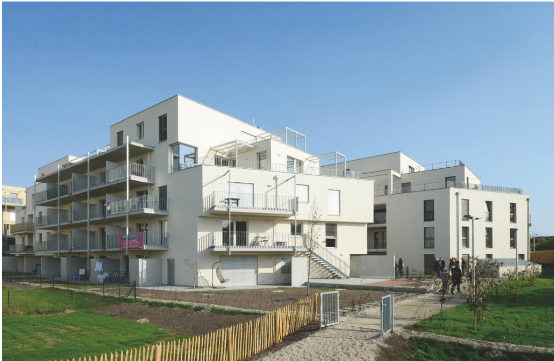
Abb.15 | Wohnanlage MGG22 (Wien,A): Heizwärme und Warmwasser wird über Sole-Wasser-Wärmepumpen mit Erdwärmefonden erzeugt. Dafür wurden 30 Erdsonden von je 150 m Länge gebohrt. In 10-20 m Tiefe sind das ganze Jahr über gleichmäßige Temperaturen von 10-12 °C.
