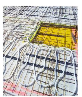
Die Rohrregister sind auf den Elementdecken verlegt und werden anschließend einbetoniert. Die Durchführungen sind mit dem Statiker abgeklärt.
