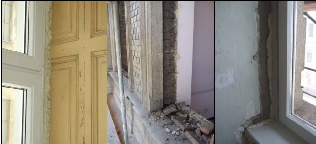
Abb. 13: Bild links: Anschluss neues Kunststofffenster alte Holzverkleidung Bild Mitte: Alter Fensterstock abgetragen Bild rechts: Fensteranschluss mit Dichtbändern
