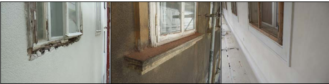
Abb. 9: Untere Fensteranschlüsse bei bündig sitzenden Fenstern
