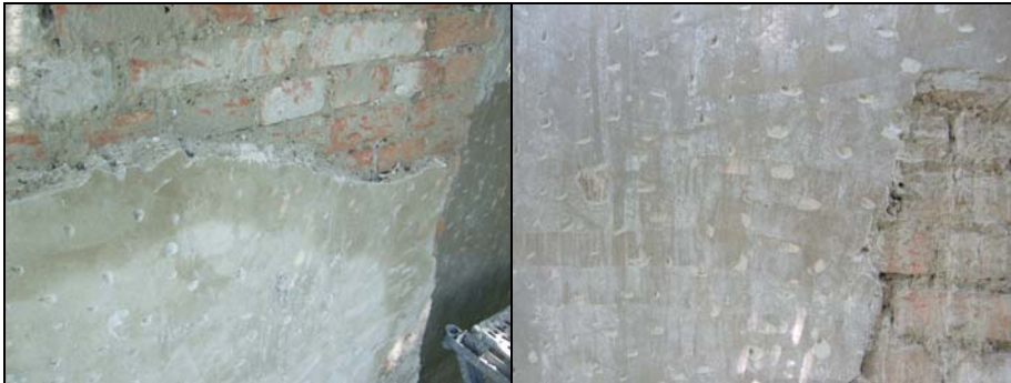
Abb. 3: Prüfung des Putzgrundes, lose Teile abgeschlagen
