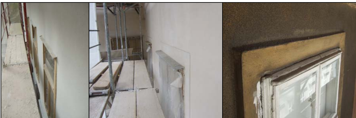
Abb. 11: Oberer Fensteranschluss bei bündig sitzenden Fenstern
