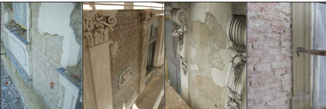
Abb. 4: abgeschlagenen Putzflächen
