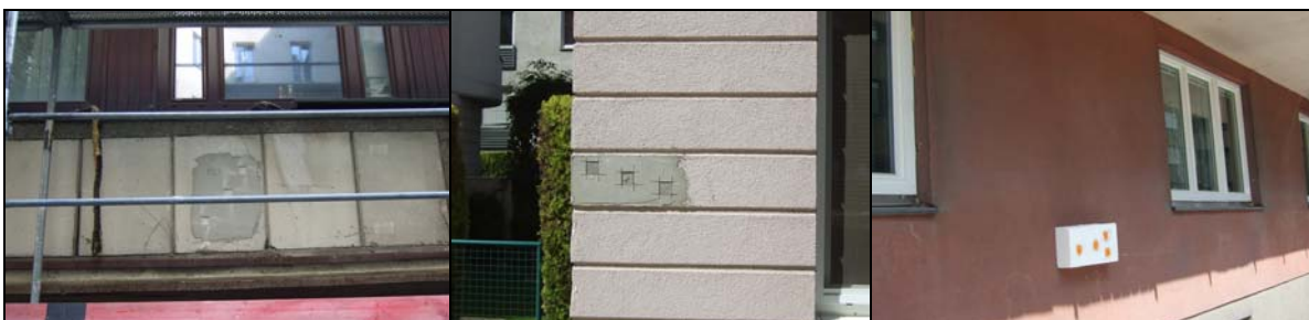
Abb. 2: links und Mitte: Prüfstelle der Haftzugfestigkeit der Unterputzes (Kleber) rechts: Verdübelungsprobestelle
