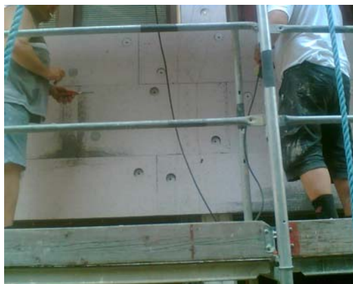
Abb. 19: Versenkdübel mit Dübelkappe
