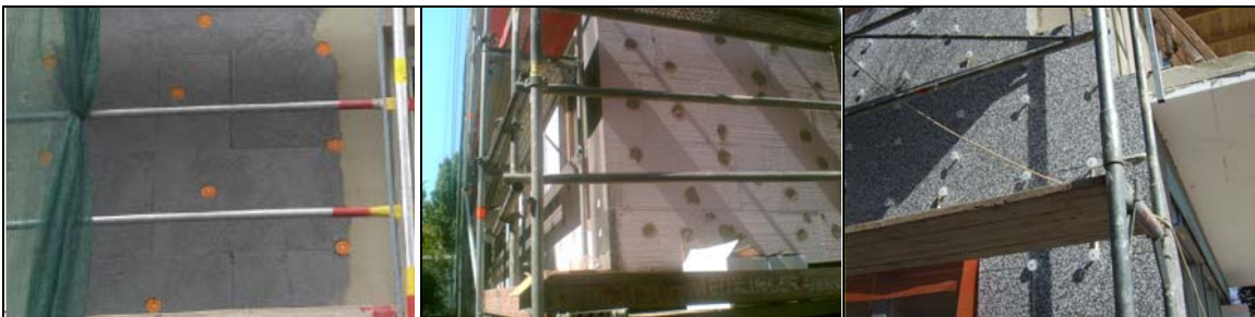
Abb. 17: Dübelschema (links) bzw. Randverdübelung (Mitte, rechts) nicht eingehalten
