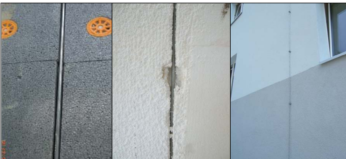
Abb. 7: links und Mitte: Blitzschutz in Wärmedämmung eingeschlizt rechts: Blitzschutz auf der fertigen Fassade befestigt
