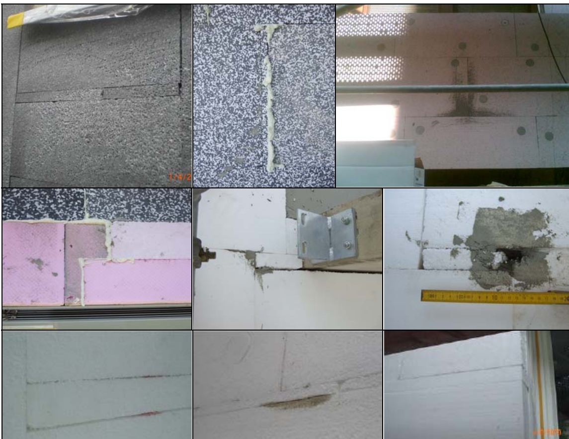
Abb. 12: eingepasste „Reststücke“, Mindestbreite unterschritten
