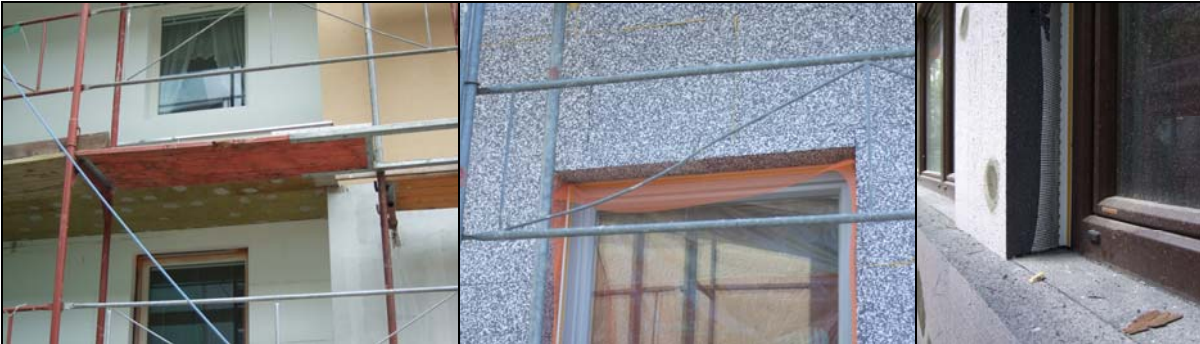
Abb. 8: Fensteranschlüsse mit Dichtbändern
