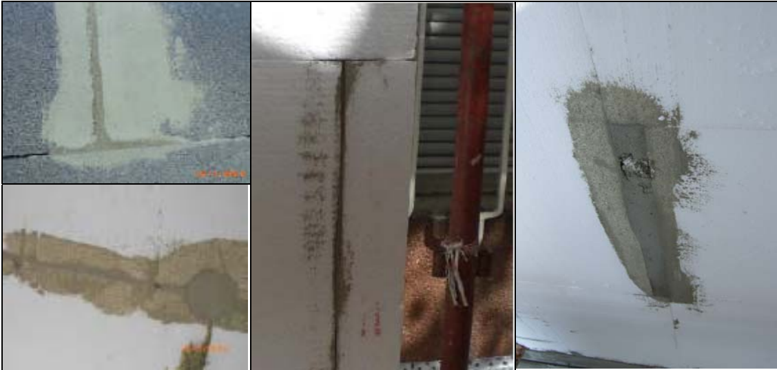
Abb. 16: Fugen mit Kleber verschlossen
