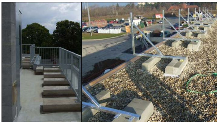
Abbildung 23: Betonfundamente für Geländer bzw. Werbepanellen
