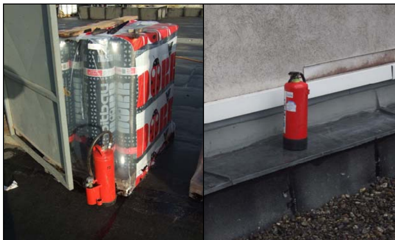
Abbildung 28: vorgehaltene Feuerlöscher auf Baustellen
