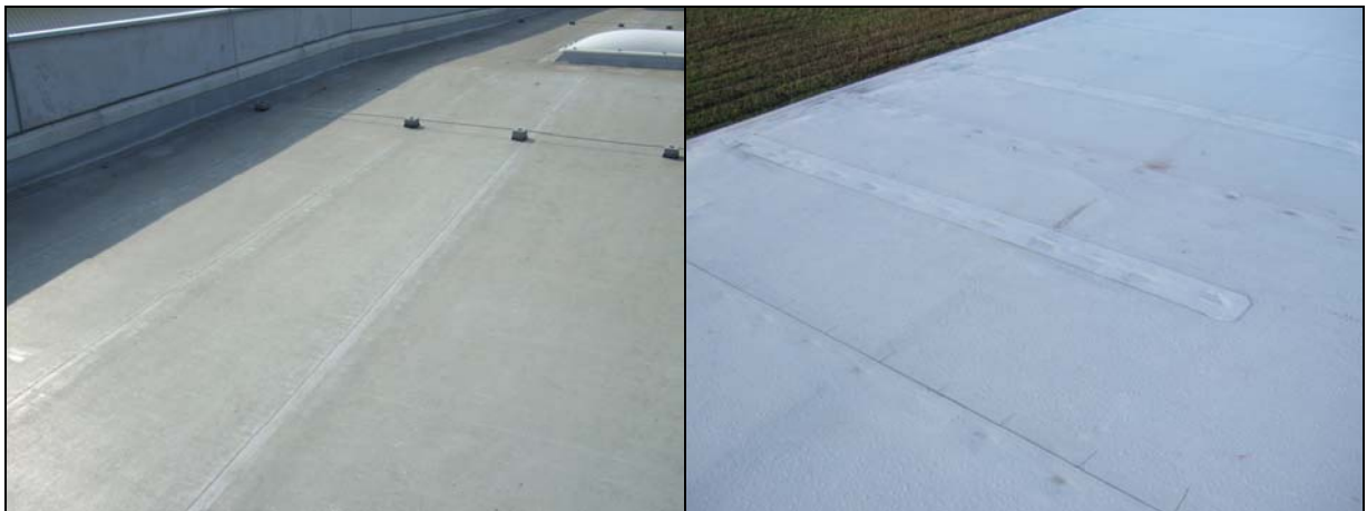
Abbildung 17: Kunststoffbahnenabdichtungen
