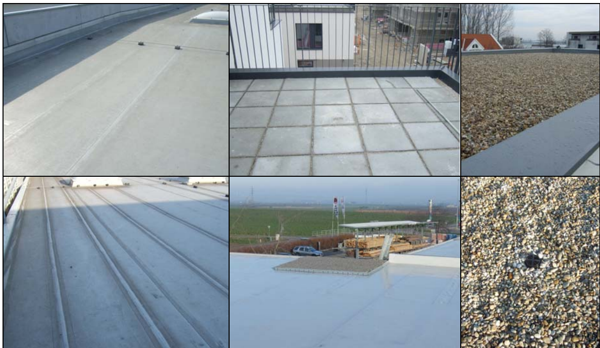
Abbildung 25: Schutz- und Nutzschichten
