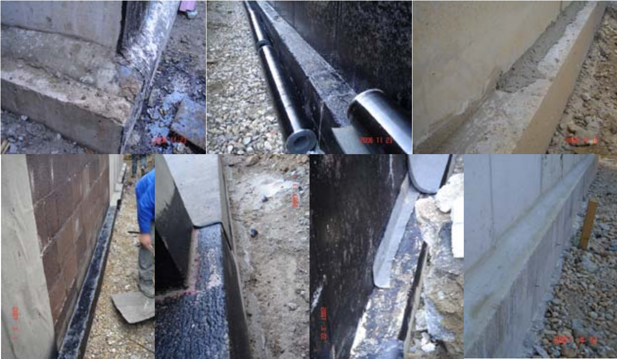
Abbildung 10: Anschluss Fundamentplatte Wand
