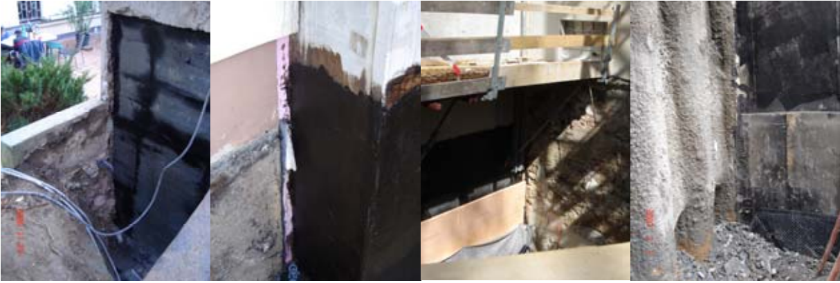
Abbildung 18: Bild links: Sanierung, Anschluss an Stützmauer beide Bilder in der Mitte: Anschluss an den Bestand Bild rechts: Neubau, Anschluss an Bohrpfahlstützmauer
