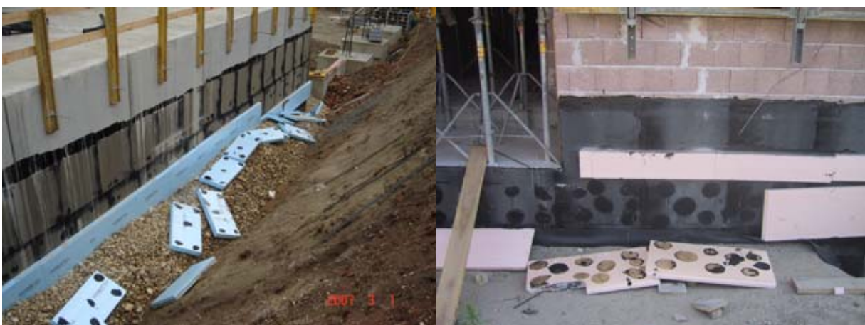
Abbildung 16: abgelöste Perimeterdämmung
