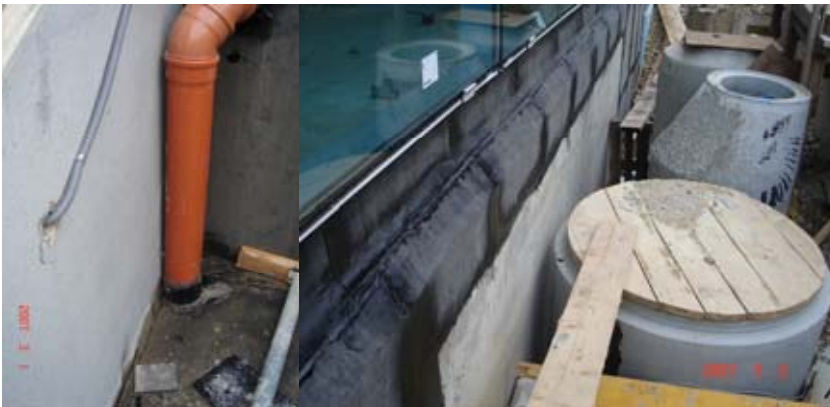
Abbildung 13: Einbauten vor der Abdichtung
