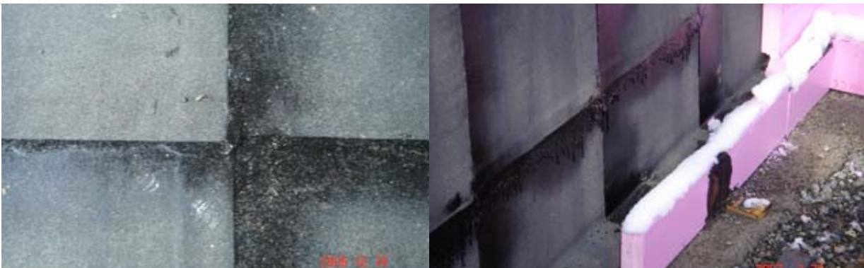
Abbildung 19: „Kreuzstöße“ von Abdichtungsbahnen
