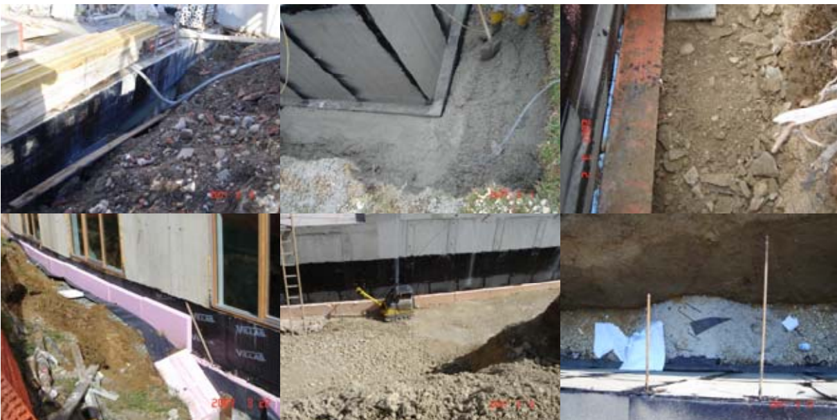
Abbildung 22: Verfüllmaterial der Arbeitsgräben
