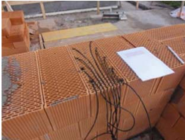
Abbildung 38: Temperaturfühler im unteren Messfeld [Ziegelbau Zukunft, 2012]
