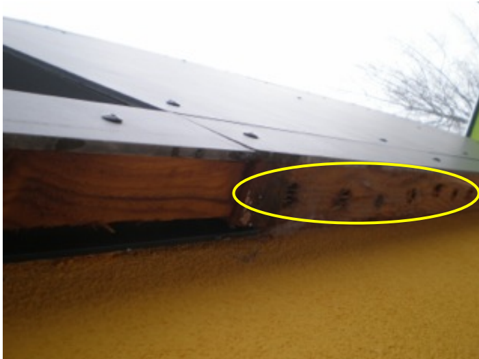
Abbildung 41: Verschattung an der Außenwand
