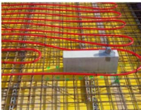
Abbildung 39: Thermische Bauteilaktivierung [Ziegelbau Zukunft, 2012]
