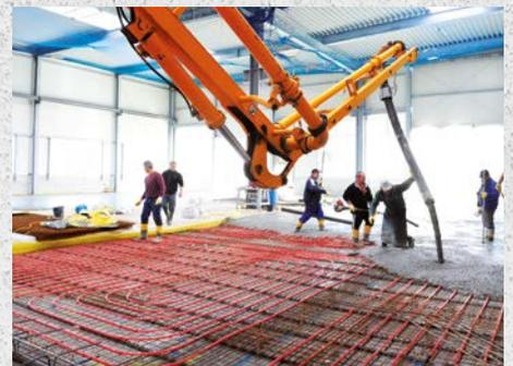
**3)** Auch im kleinen Rahmen eines Einfamilienhauses ist Bauteilaktivierung möglich und sinnvoll. Matthias Kainhofer hat beispielsweise sein Haus in Munderfing mit einer aktivierten Bodenplatte aus Beton ausgestattet: Das Haus heizt mit Erdwärme und wurde innerhalb eines Jahres errichtet. Die Innentemperatur ist seitdem immer auf der Wohlfühltemperatur von 22 Grad.
