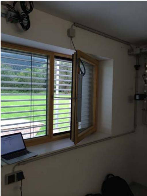
Abbildung 7: Öffenbare Fenster in den Ziegelhäusern. Im Foto ist die größte Öffnung des Fensters zu sehen. Erkennbar ist auch der außenliegende Sonnenschutz in der Stellung geschlossen.
